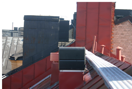
3. Även i fjärrvärmvärmda äldre hus kan energi sparas med frånluftvärmepump.
